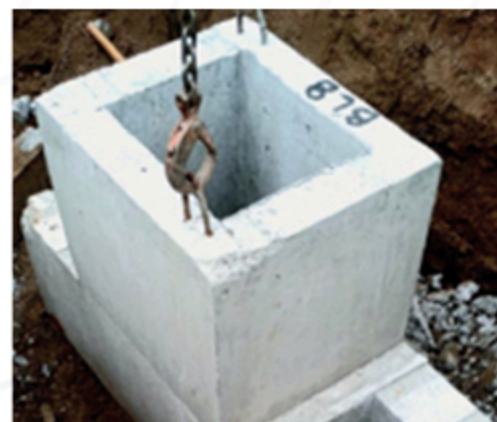
BLOCOS DE FUNDAÇÃO
